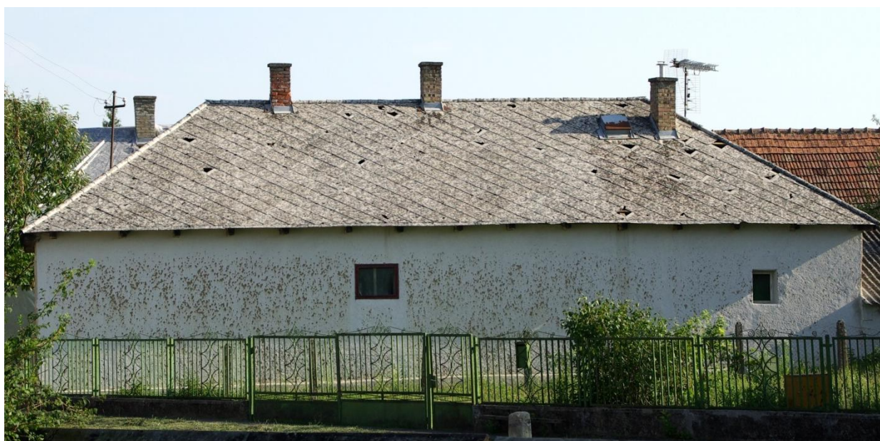
17. ábra. Egy vályogfalazatú, palával fedett lakóház állapota jégverés után a Vásárosnaményi járás egy településén
