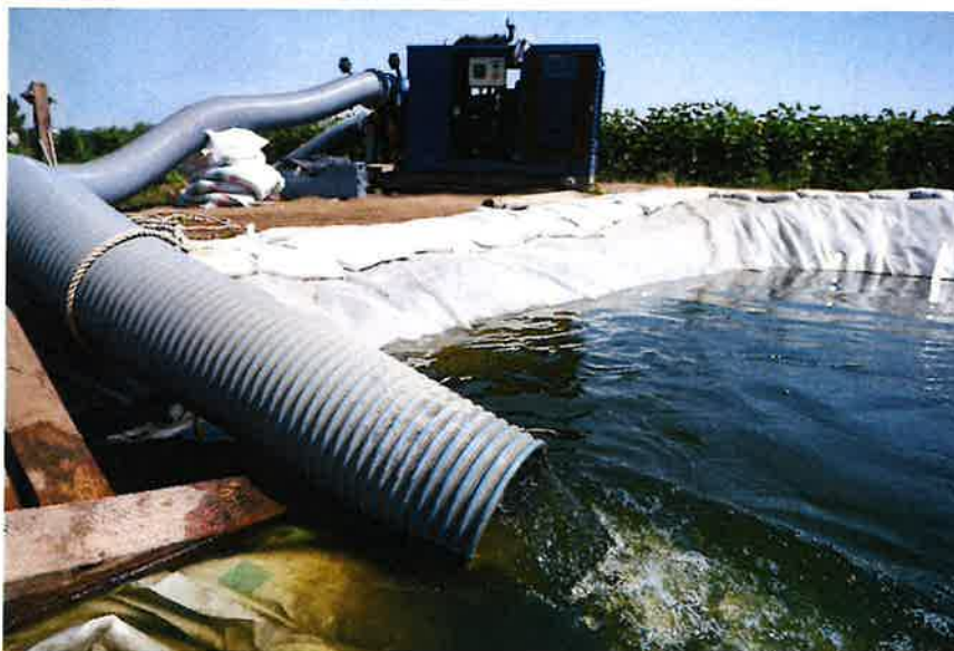
6. fénykép. Ideiglenes mederátöltés és szivattyús vízpótlás 2022 júniusában, Felsőszabolcsban
